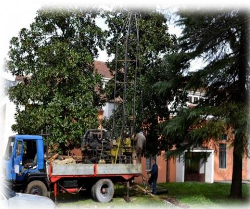
Na dosadašnjem projektu sprovedena su geološka i hidrološka istraživanja. Urađena je istražna bušotina nadomak Centra za kulturu dubine 50 metara u kojoj su postavljene cijevi, unutrašnji prečnik cijevi iznosi oko 125 milimetara -12,5 cm. Protok vode kroz cijevi koji je dobijen bušotinom iznosi 7,2 l/s, dok izmjerena temperatura vode pokazuje 14°C. Projektni zadatak je urađen. Ubrzo će biti raspisan tender za Glavni projekat, a potom tender za izvođenje radova.
